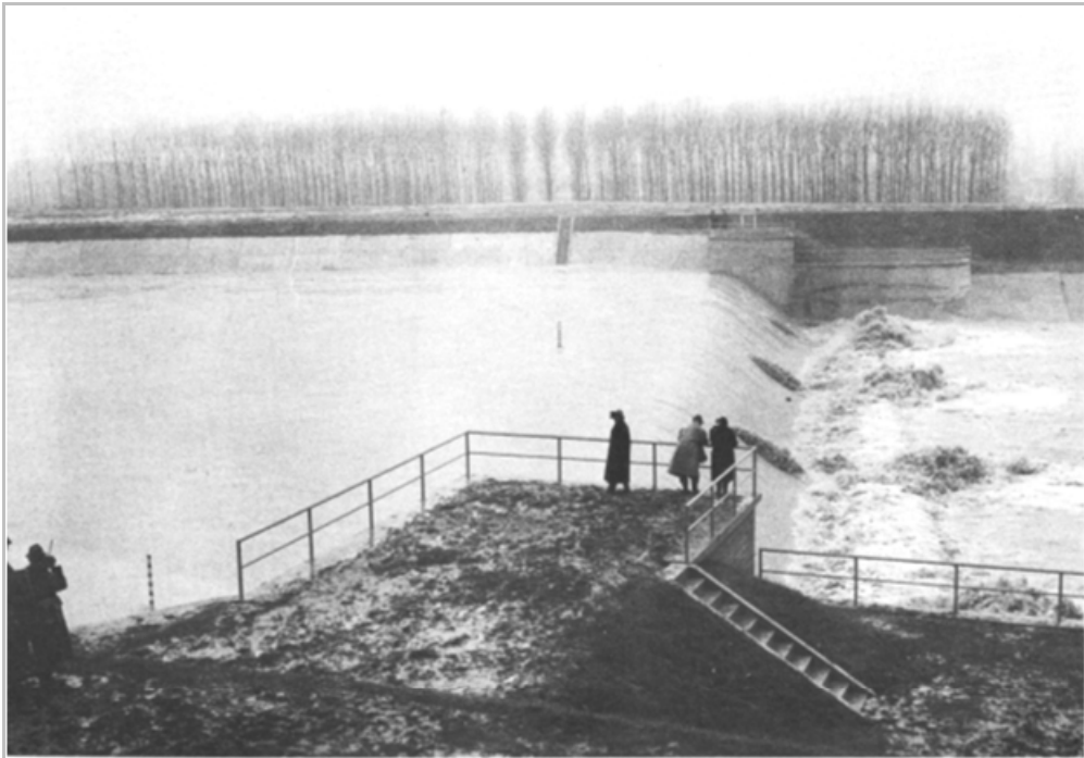
Figura 6-9. Attenuatore delle piene del fiume Reno in esercizio
