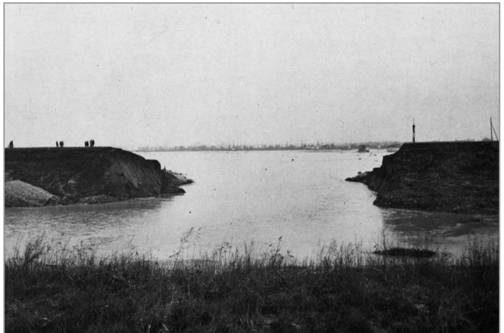
Figura 9-15. La rotta dell'argine sinistro del fiume Reno in località Gallo (Poggio Renatico) nel novembre 1949
