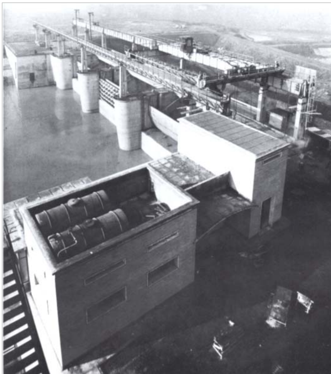
Figura 6-8. Attenuatore delle Piene del fiume Reno (Cavo napoleonico): opera di scarico da Reno (Fonte: Bruno Cassarini, La difesa del territorio dalle piene del Po e del Reno , Gabriele Corbo Editore, 1990)
