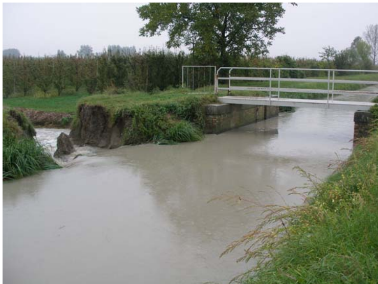
Figura 9-4. Rotta Canale di Cento
