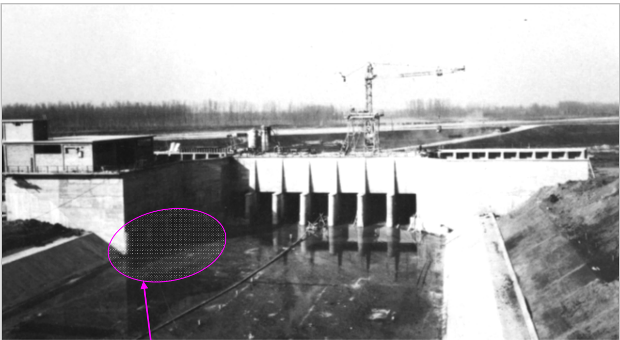
Figura 6-14. Attenuatore delle piene del Fiume Reno: costruzione della chiavica per lo scarico in Po (1958). Si notano sulla sinistra le tre bocche di scarico del vicino impianto di sollevamento da Po di Palantone, per l'utilizzazione ai fini irrigui dell'attenuatore (Alessandro Denaro e Giorgio Vighi, Dalla ricostruzione postbellica ai giorni nostri , Gabriele Corbo Editore, 1990)
