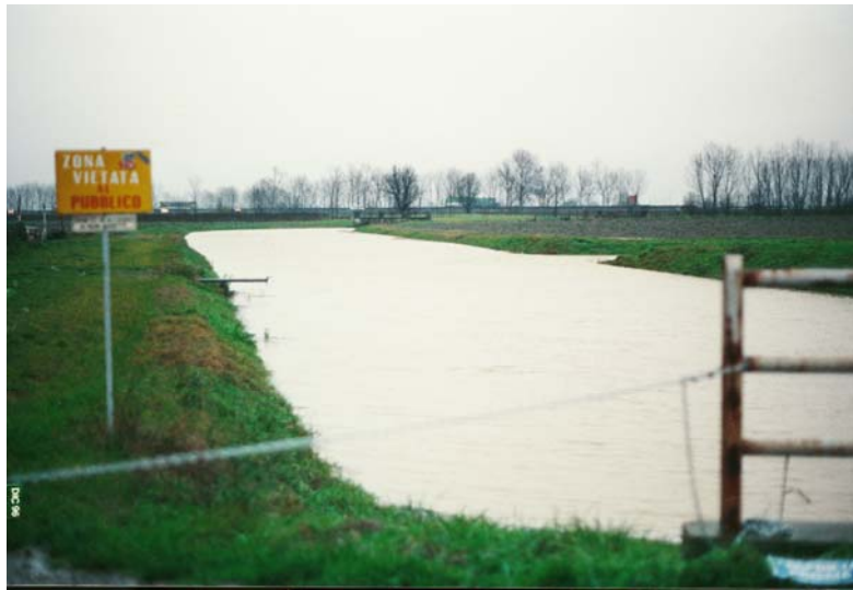
Figura 9-7. Il Canale Torniano a Monte dell'impianto
