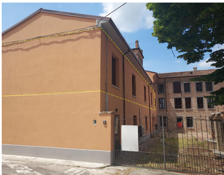
Foto prospetto nord-est
