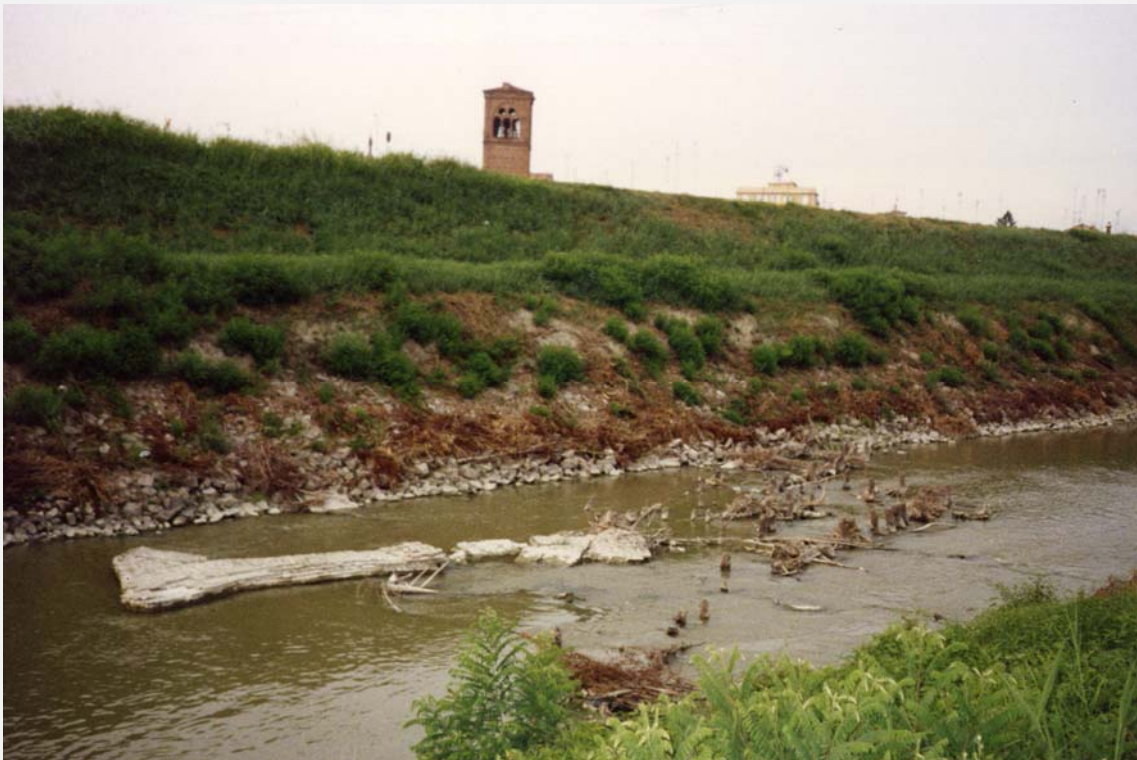
Bondeno, Fiume Panaro: affioramento di mura urbane
